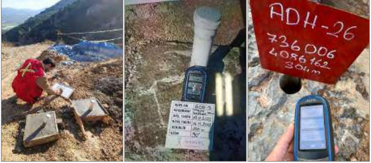
Şekil 72 Kuyu başı betonu, levhası ve etiketlemeleri.
