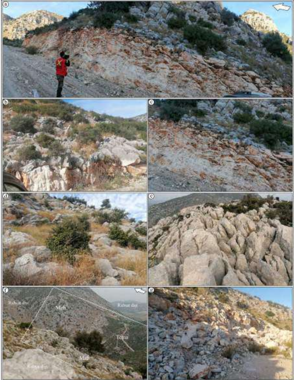
Şekil 53 Beyaz ve bej renkli kireçtaşlarının arazideki genel görünüşleri.
