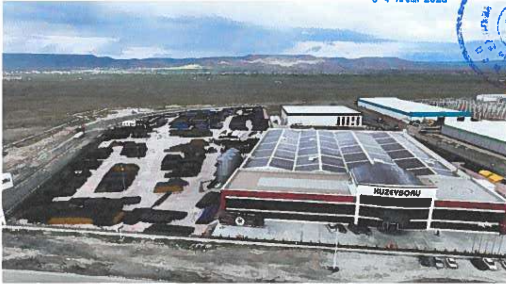
Resim 1: Kuzey Boru Merkez Fabrika Binası
