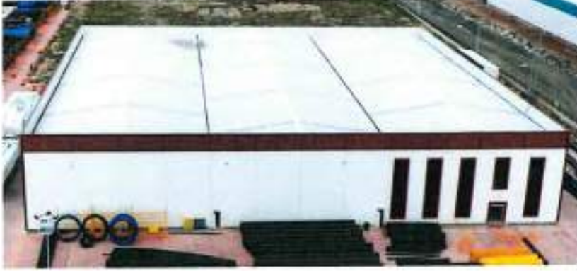
Koroze Boru Üretim Tesisi
