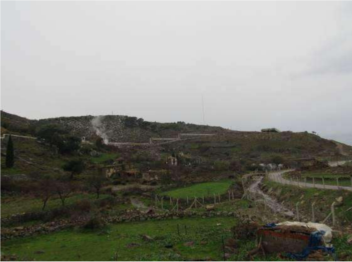
Tesisin Görünümleri Türbin ve Jeneratör Üniteleri
