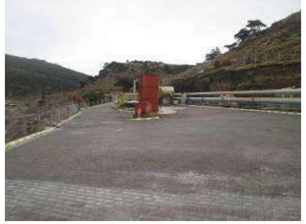
Boru Hattı ve Re-Enjeksiyon Pompası 1
