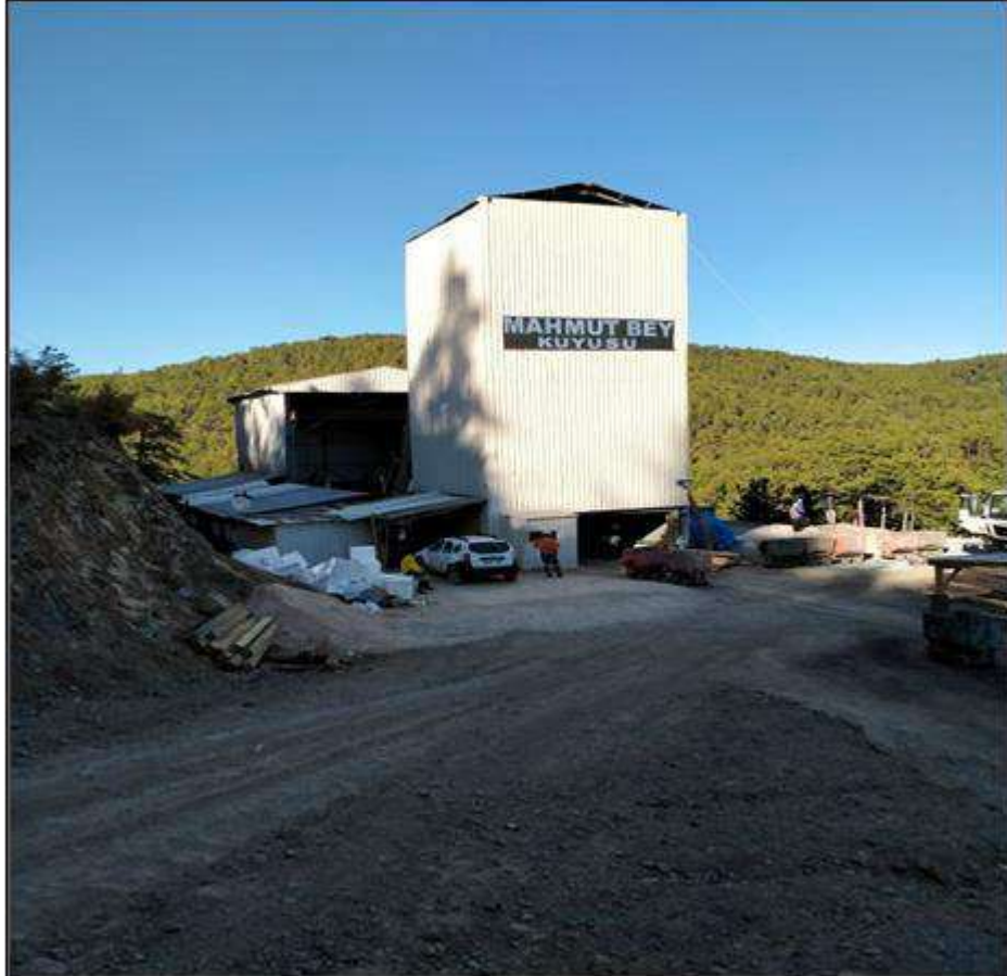
Foto 4: Mahmut Bey Kuyusu Yeraltı İşletmesi Girişi
