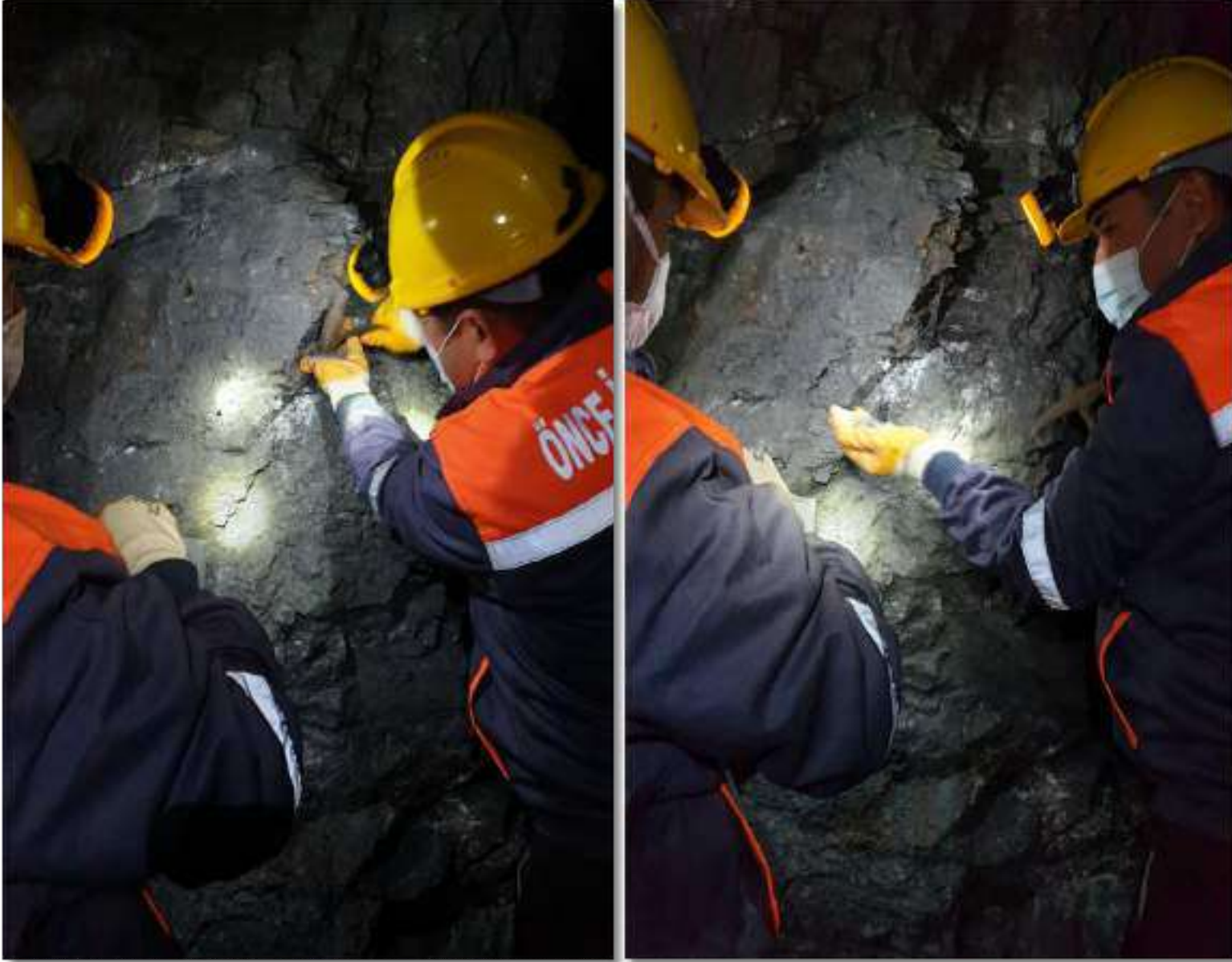
Foto 9: Yeraltı Galerisi Cevher Örnekleme Çalışması
