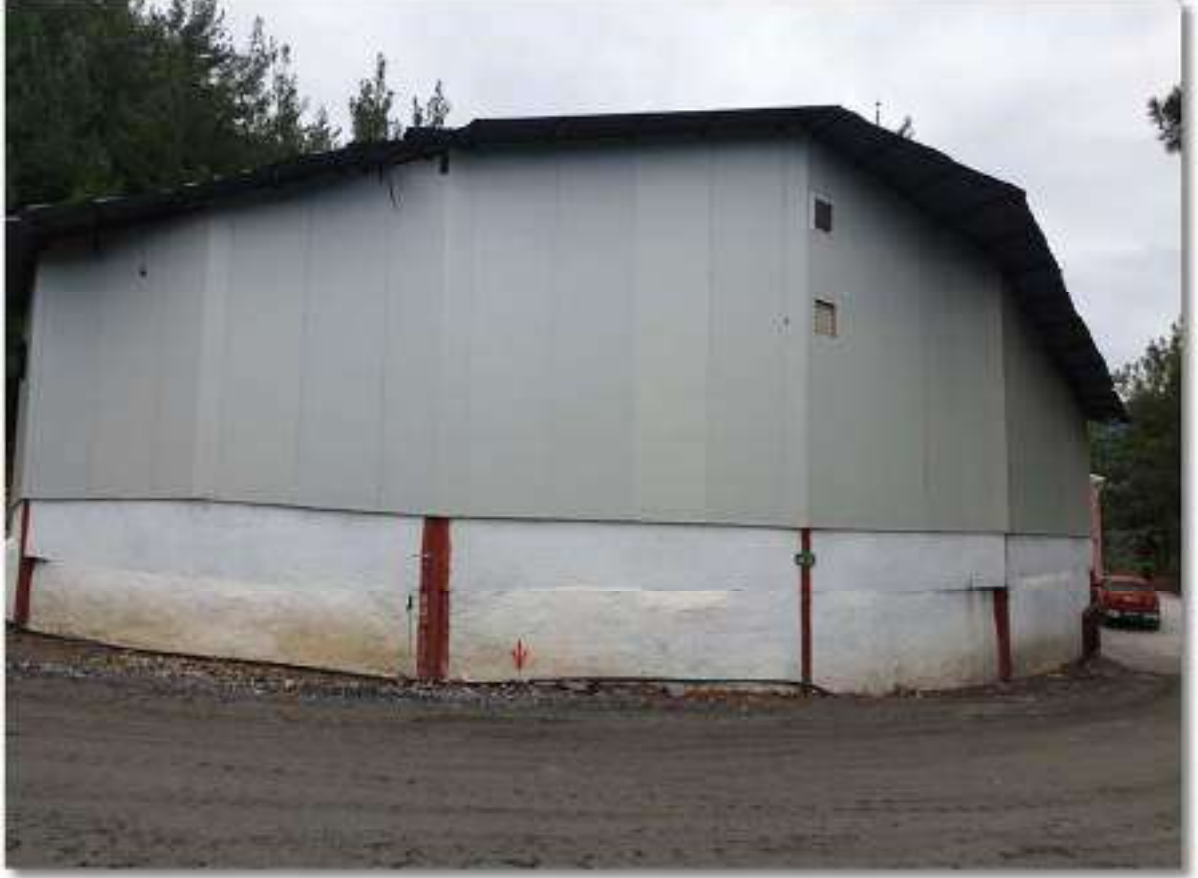
Foto 10: Örneklenen Karot Numunelerinin Saklandığı Depo
