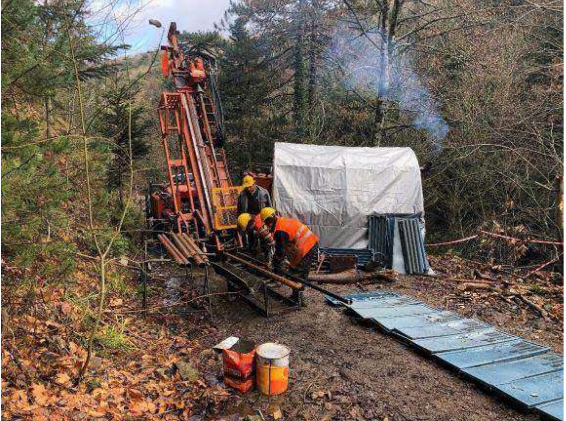
Foto 12: Spiral Ocak Bölgesi Sondaj Çalışması
