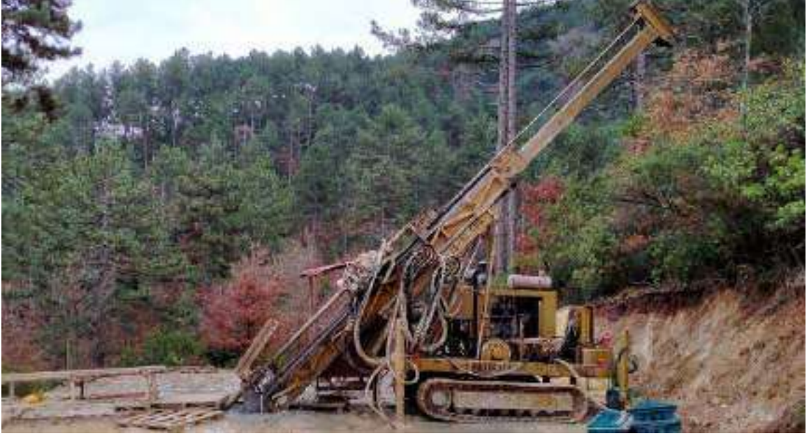
Foto 11: Doma Sahası Sondaj Çalışması
