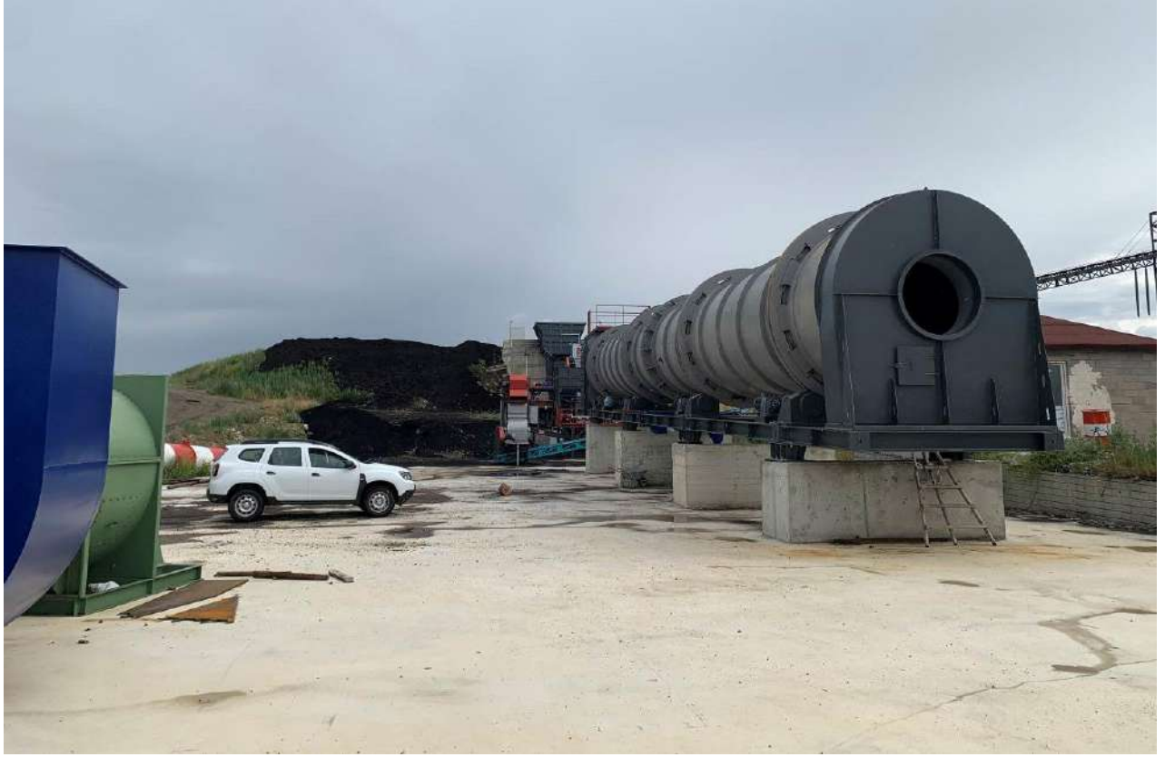
Resim 7: GK-20, Kurutma Tesisi (Kurulum Aşamasında)
